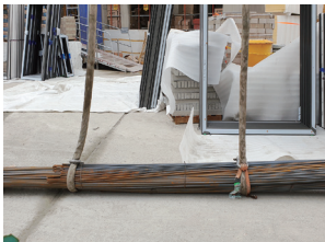
줄걸이 결속상태와 유도로프 확인
