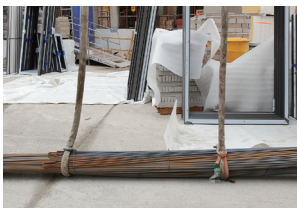
줄걸이 결속상태와 유도로프 확인
