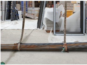
줄걸이 결속상태와 유도로프 확인
